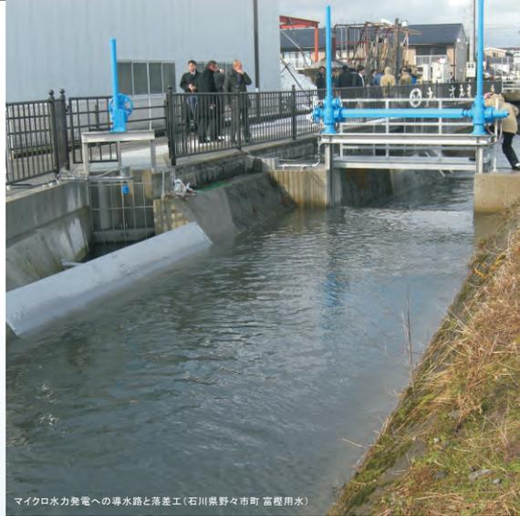
マイクロ水力発電への導水路と落差工(石川県野々市町 富樫用水)
