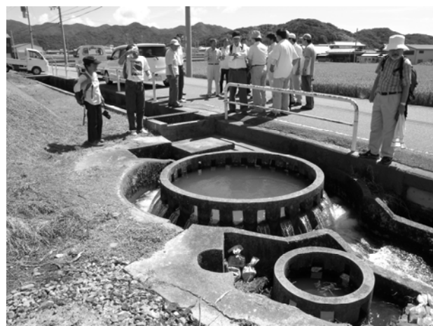
写真2 上田池土地改良区円筒分土工にて
