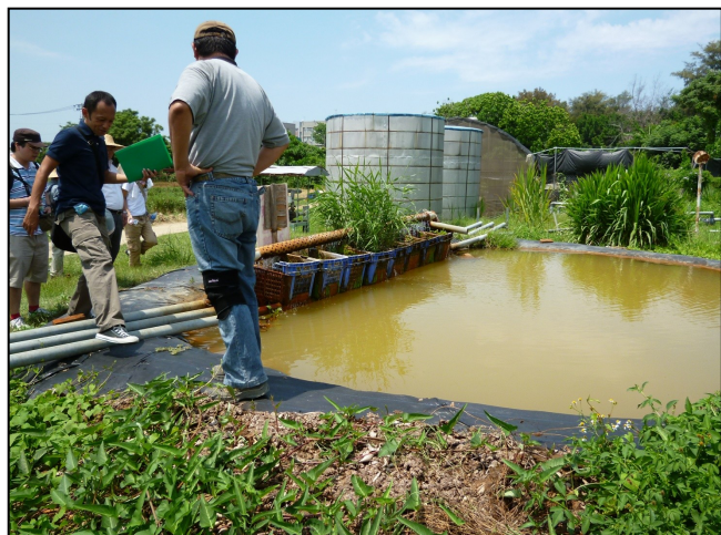
写真3 台南巨農農場の地下水の鉄分除去池
