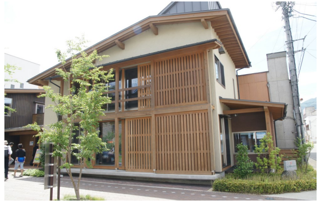
写真-2 エコハウス
