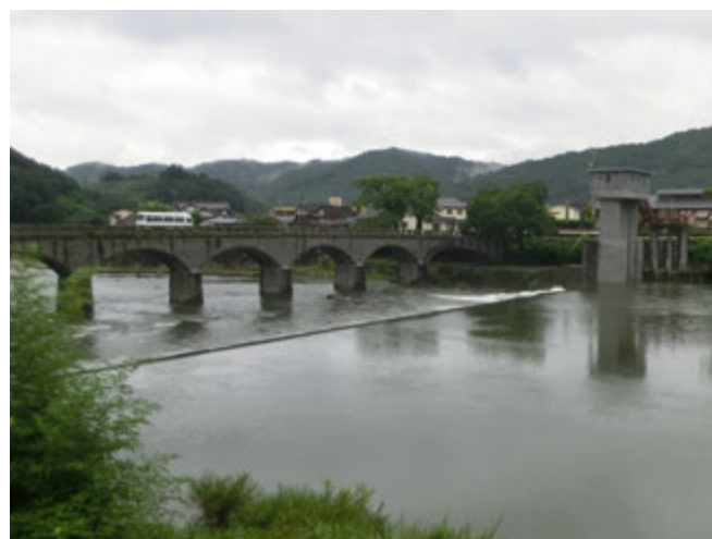
(写真9：耶馬溪橋)
