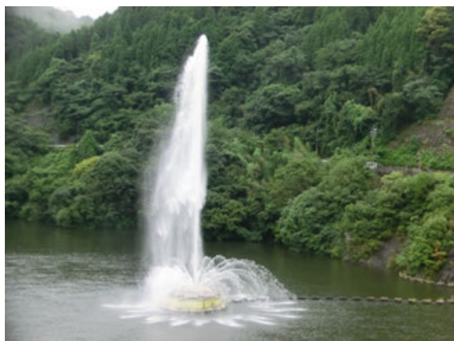
(写真7：貯水池循環装置による噴水)
