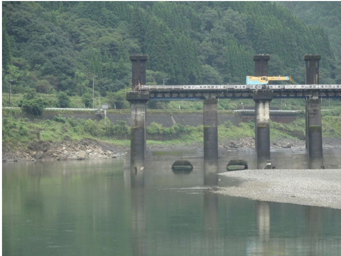
写真7 ダム基底部には、堆積土砂の吐出口が開けられていた
