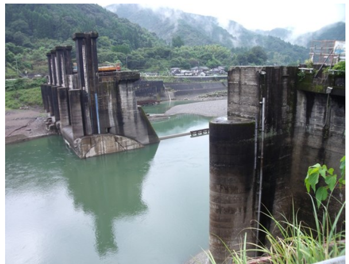
写真9 撤去中の荒瀬ダム
