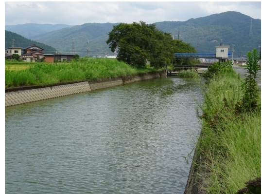
余呉川導水路
