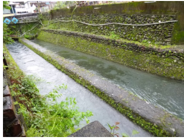
地下ダムからの導水路
