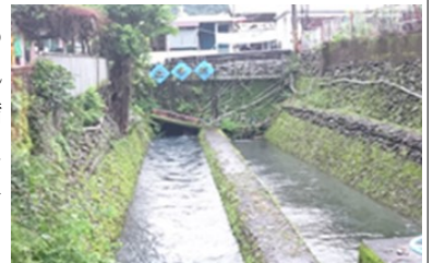
地下ダムの導水路
