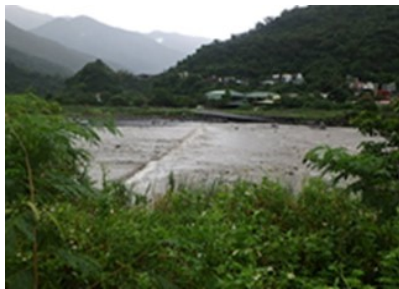
扇状地入り口の地下ダム
