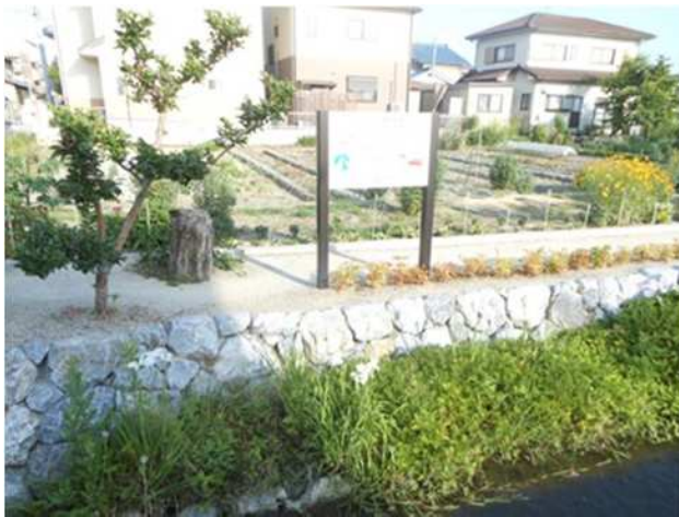
地域用水機能増進事業で整備された水路
