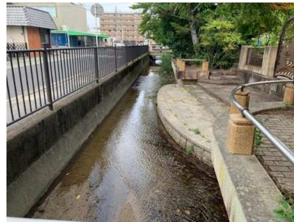
用水路（祇王井川の上流側）
