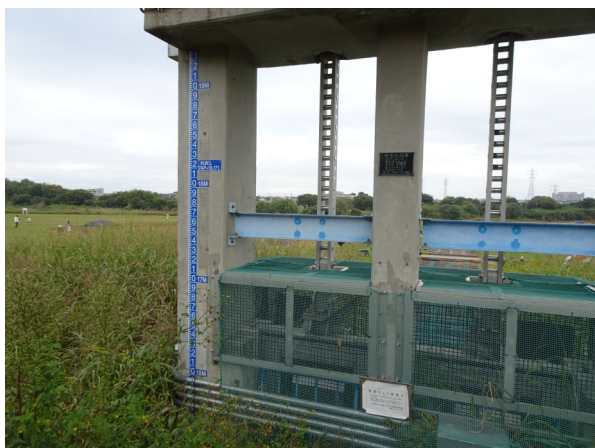
写真3：宇奈根排水樋管
